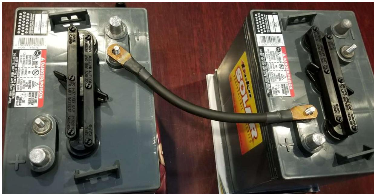
Para aumentar el voltaje, debo conectar la batería de un polo positivo a un polo negativo y luego ponerle los tornillos a cada polo.
